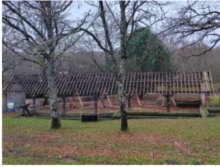
Début de la reconstruction du mur du lavoir
