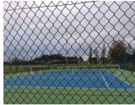
Finitions des travaux au tennis, peinture du sol
