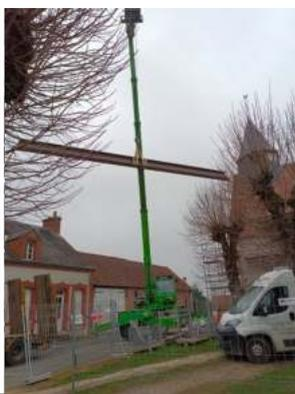
*Renforcement de l'assise du clocher à l'aide d'une poutre IPN en acier*
