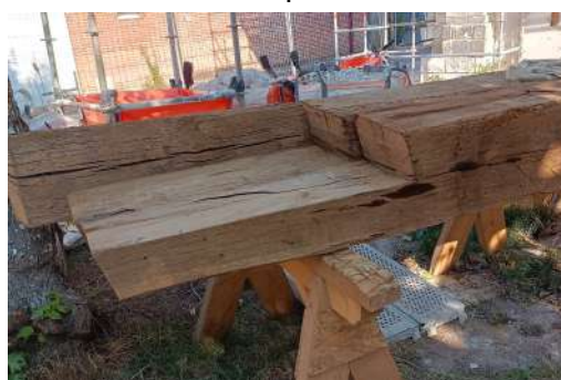
Préparation des poutres saines avant remplacement
