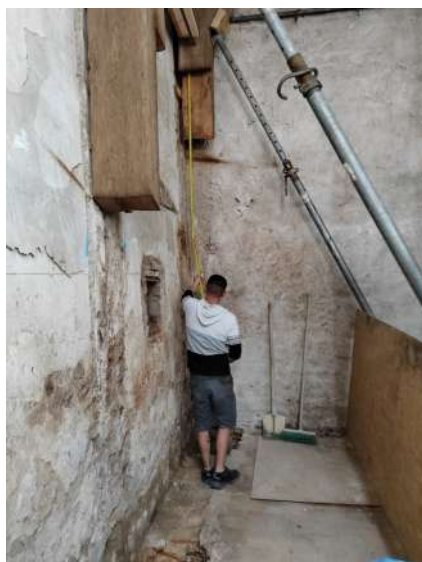
Mise en place d'étais pour préparer le remplacement des parties pourries
