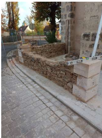
Construction du muret support de la charpente du caquetoire
