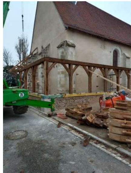
Mise en place de la charpente du caquetoire
